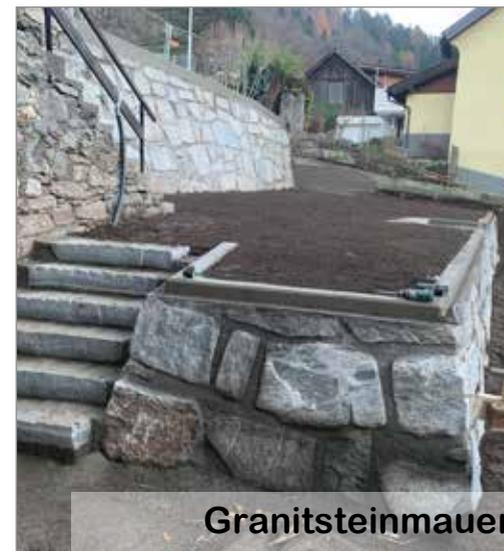
**Granitsteinmauer in Beton verlegt**
